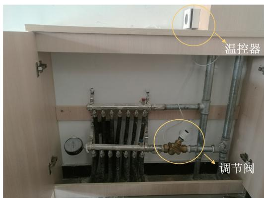
图 3 A 区温控器+调节阀的现场安装
