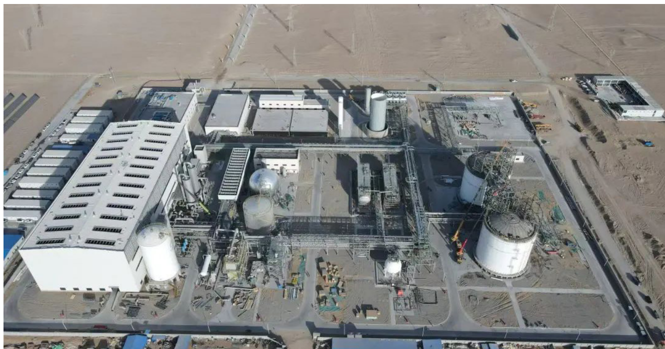
60MW/600MWh液态空气储能示范项目建设现场
