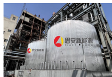
建龙实业高炉煤气加热熔盐储热调峰示范项目
