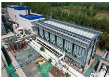
华能德州电厂电加热模块化熔盐储能调峰调频示范工程
