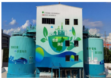
江苏国信靖江电厂电加热熔盐储热供蒸汽调峰示范工程
