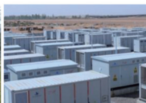
电化学储能 标准储能柜、储能集装箱
