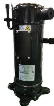
图2.3-3 广州万宝集团有限公司R32 制冷剂大容量变频涡旋压缩机
