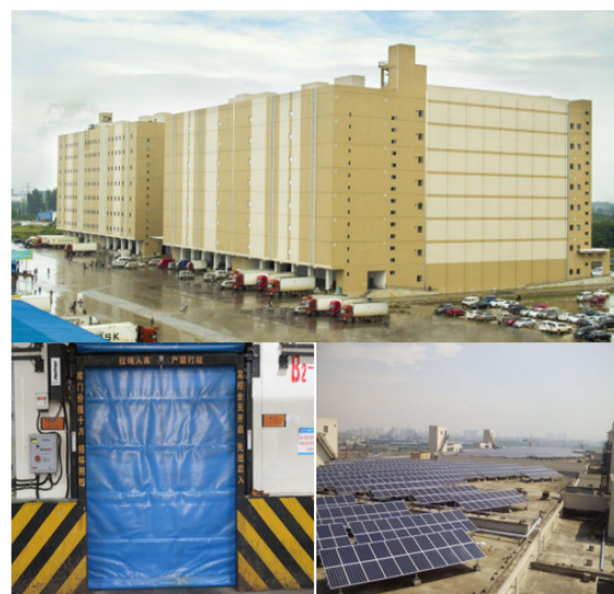
图3.3-6 光伏保温节能冷库
