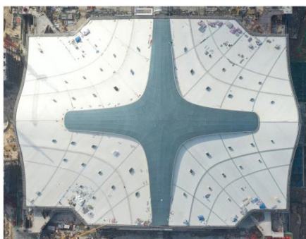
(a) 杭州西站站房屋面
