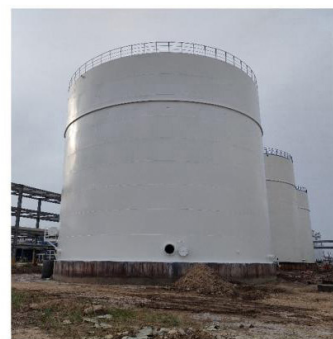
(e) 山东东营石化储罐
