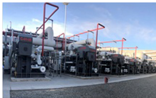
图7.2-2 新疆某多晶硅(复叠系统R1270/R1150-87℃蒸发)
