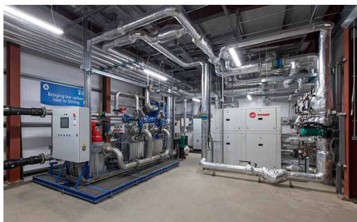
图2-9 美国特灵新型螺杆式冷水机组
