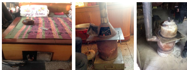
(a) 传统火炕 (b) 取暖炉 (c) 煤炉
