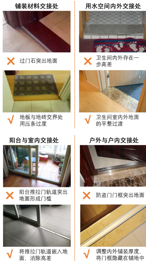
图6 住宅中常见的地面高差问题及对应的正确处理 方式
